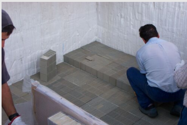
Pose de blocs céramiques
