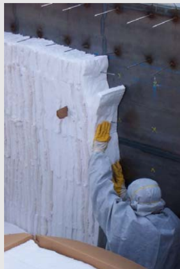
Pose de fibre céramique
