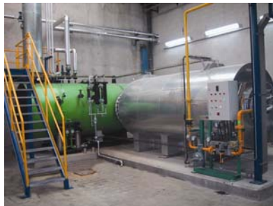
Instalación de oxidación térmica recuperativa con valorización de hidrocarburos residuales de los puertos (marpol) como combustible para generar vapor
