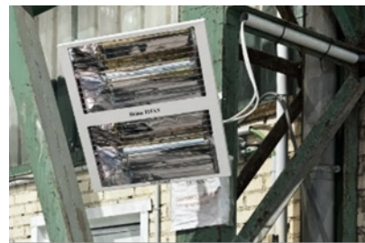
Figura 2- Nuevo sistema: Módulo de calefacción eléctrica radiante
